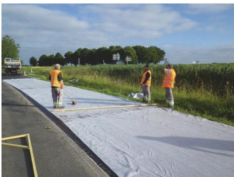
Figure 10. Pose manuelle du géotextile.
