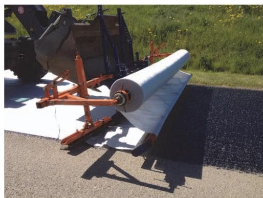
Figure 13. Avec la machine actuelle, difficultés pour corriger la trajectoire sans créer des plis.
