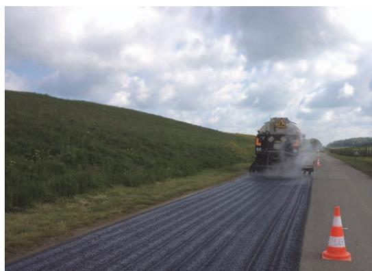
Figure 12. Peignage inévitable lors d'un répandage  $\leq 600$  g/m<sup>2</sup> avant déroulage du géotextile.
