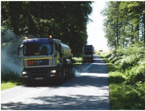
Figure 8. Atelier traditionnel de mise en œuvre d'enduit superficiel.
