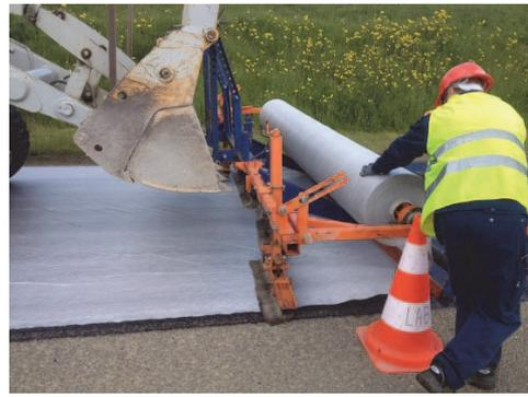
Figure 9. Dérouleur mis à disposition par le fournisseur de géotextile.
