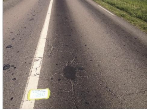
Figure 5. Fissures avec épauffures et rebouchage ponctuel.
