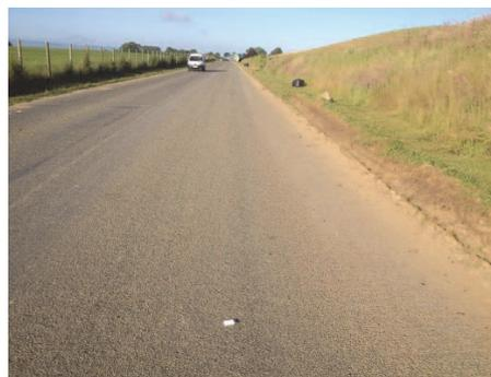
Figure 15. Pré-chantier de Fresnoy-Folny. Aspect après passage des dumpers et balayages, (ESRG appliqué uniquement sur la voie de droite).
