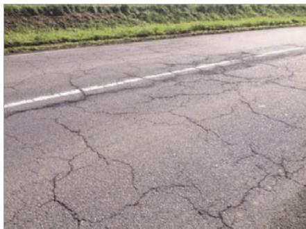
Figure 1. Cas où un ESRG est envisageable en substitution à un enduit superficiel traditionnel devenu mal adapté.
